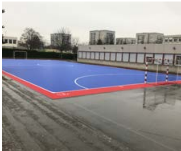
TERRAIN EXTÉRIEUR, VÉNISIEUX
